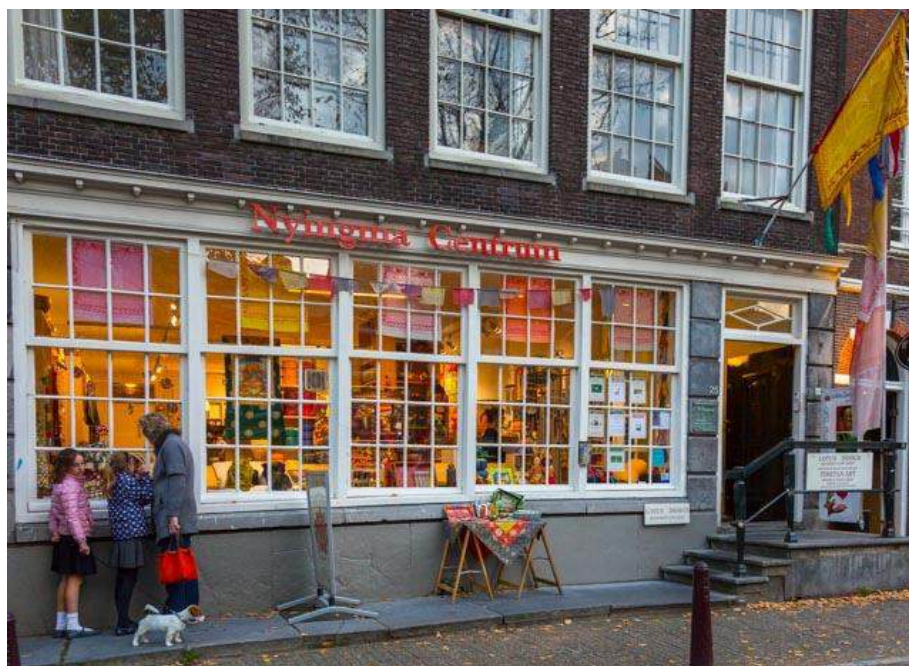
Voorzijde gebouw Nyingma Centrum Nederland aan de Reguliersgracht
