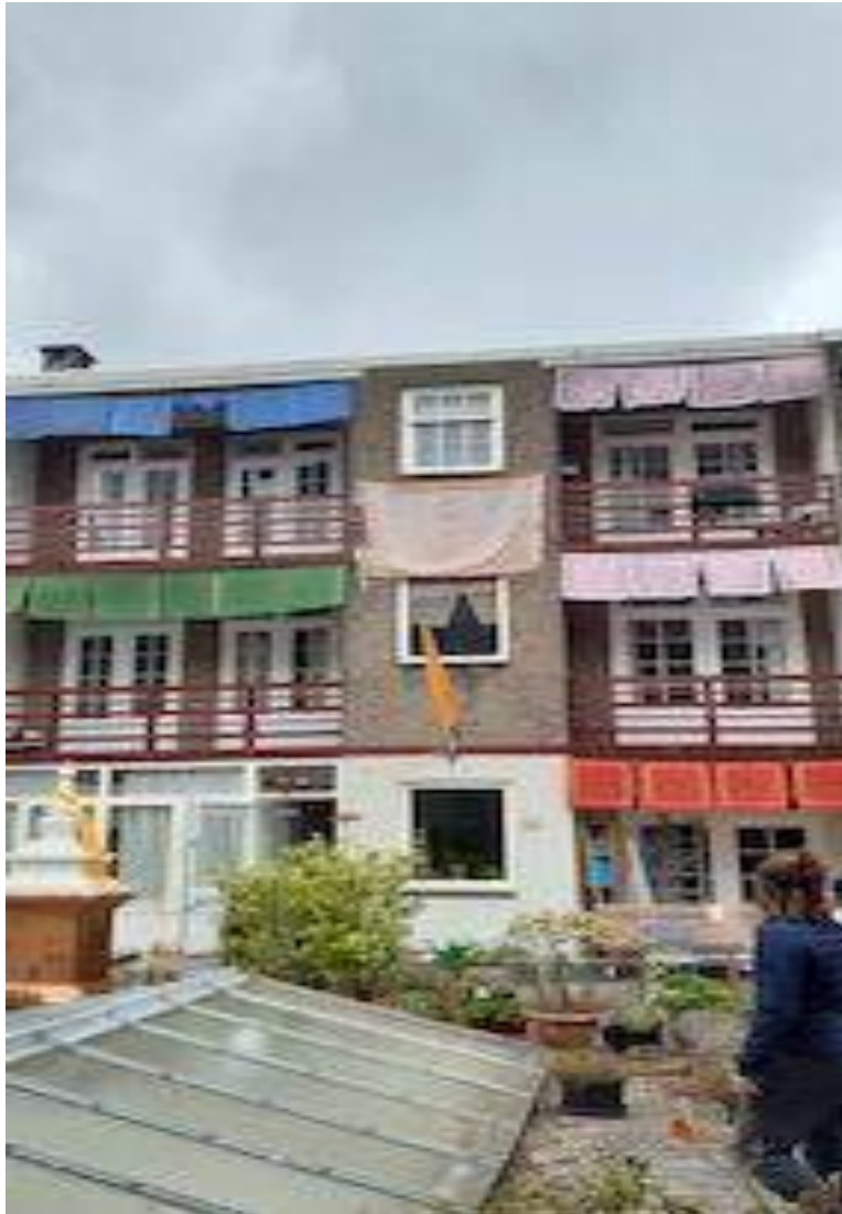
Achterzijde van het NCN-gebouw aan de Reguliersgracht
